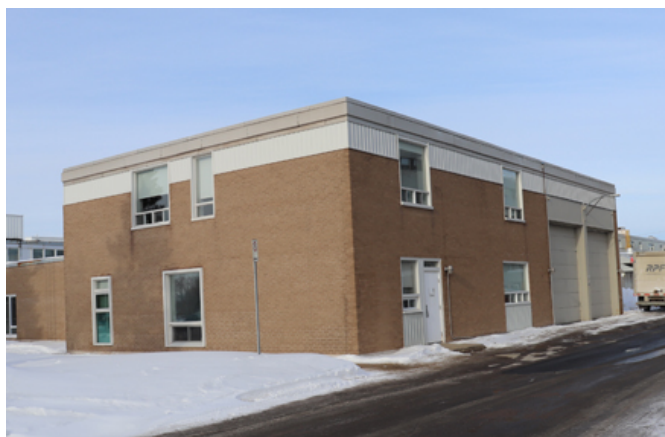
104. L'ancien poste de police et d'incendie dans son état actuel. Le bandeau de fenêtres qui ceinturait l'immeuble au sommet des façades est disparu.
