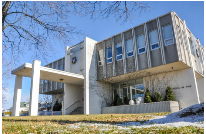
132. L'hôtel de ville de Magog, aménagé sur deux étages, comprend également une section réservée au service d'incendie de la ville.
