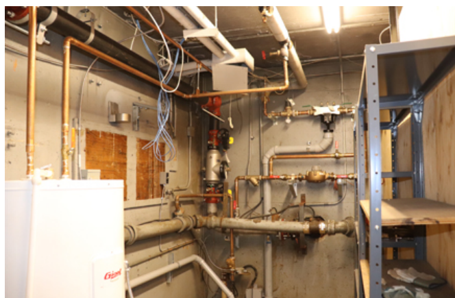
96. Salle de mécanique au sous-sol de l'ancienne bibliothèque municipale.
