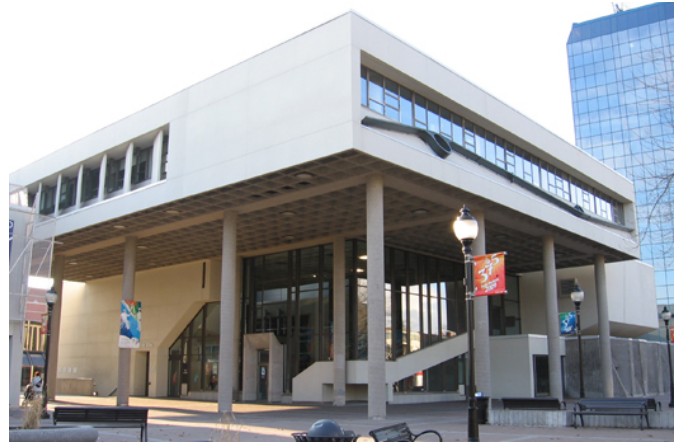
137. L'hôtel de ville de Trois-Rivières, reposant en grande partie sur de hauts pilotis, fait partie d'un ensemble civique qui comprend également un centre culturel et une bibliothèque. L'ensemble a été conçu en 1965-1968 par les architectes Leclerc et Villemur et Denoncourt et Denoncourt. Il s'agit d'une œuvre moderne audacieuse et expressive.
