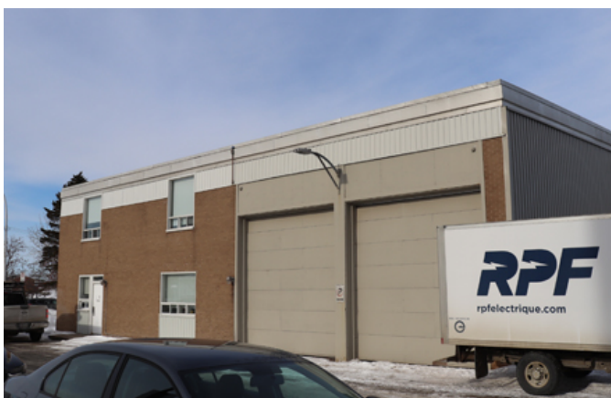
105. La façade est avec ses deux imposantes portes de garages. Les deux fenêtres à l'étage n'existaient pas à l'origine.
