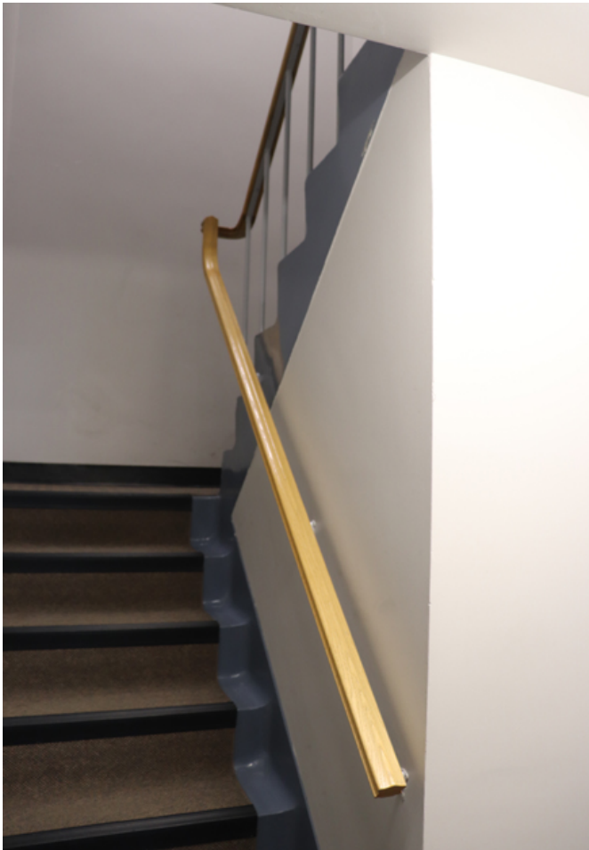
100. Escalier d'origine menant du rez-de-chaussée à l'étage.
