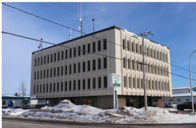
150. Immeuble commercial moderne (106, rue Napoléon), dont les façades sont constituées de panneaux de béton préfabriqués.
