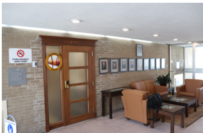
86. Ouverture percée et porte ajoutée dans le hall d'entrée de l'hôtel de ville lorsque les locaux de l'ancienne bibliothèque ont été réaménagés en mairie.
