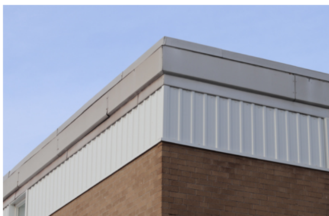
108. Détail de la bande de tôle profilée qui obstrue l'ancien bandeau de fenêtres qui ceinturait l'ensemble de l'immeuble.
