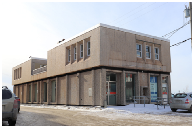
148. Immeuble commercial (455-457, avenue Arnaud) dont les façades sont composées de panneaux de béton préfabriqués.
