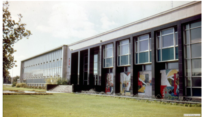
131. L'hôtel de ville d'Arvida, œuvre des architectes Dallaire et Gravel, est monumental avec ses grands murs-rideaux en aluminium, verre et granit. La section administrative et la section réservée au service d'incendie sont clairement lisibles dans l'architecture fonctionnaliste.
