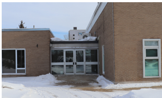
87. Le vestibule qui servait d'entrée à la bibliothèque a été entièrement condamné. Un nouveau sas d'entrée a été aménagé en avancée afin de donner accès aux bureaux dans l'ancien poste de police et d'incendie (à droite).
