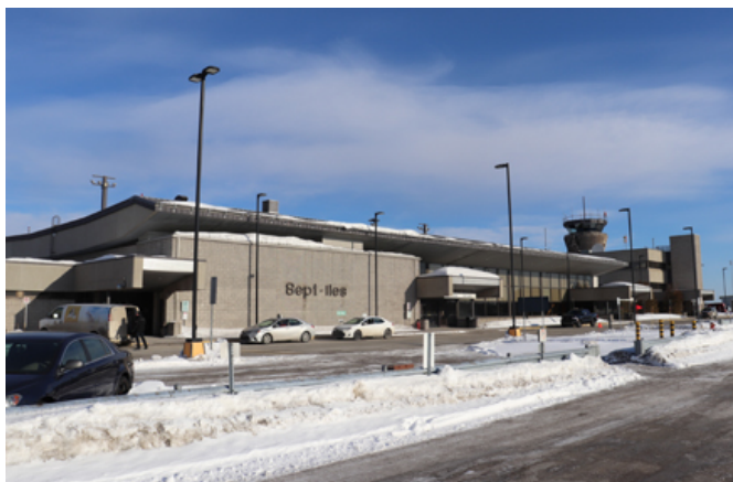
153. L'aérogare de Sept-Îles (1000, boulevard Laure), œuvre des architectes St-Gelais, Tremblay de 1974.
