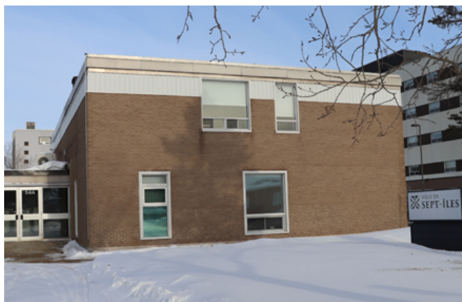
103. Façade sud donnant vers l'avenue De Quen. À l'origine, seule la fenêtre du bas au centre existait. Les trois autres ont été percées plus récemment, sans alignements.
