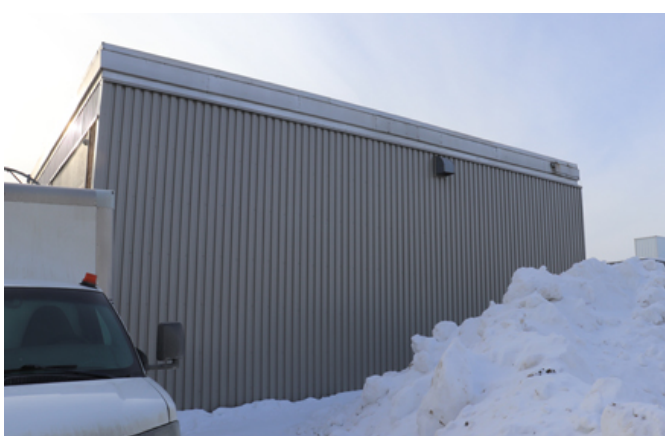
106. La façade nord, aujourd'hui revêtue de tôle profilée.
