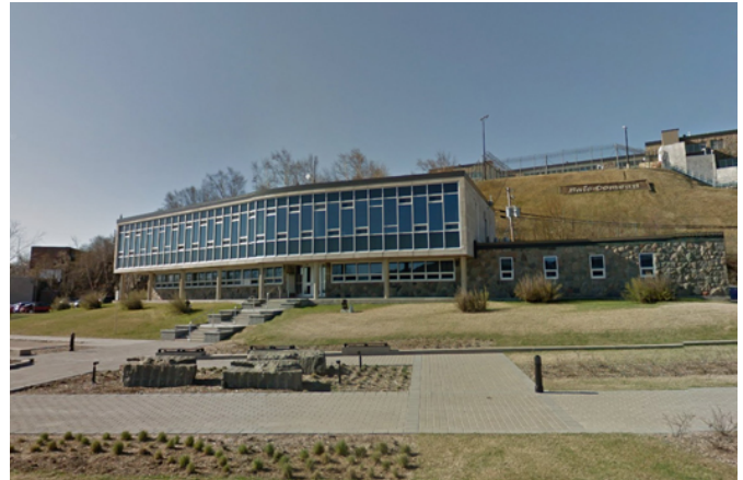
138. L'hôtel de ville de Baie-Comeau, construit en 1962 selon les plans des architectes Fiset et Deschamps, fait partie d'un complexe civique qui comprend également un palais de justice et un bureau de poste.
