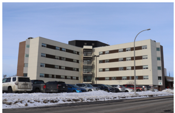
155. Le centre hospitalier se démarque davantage par son volume imposant de plusieurs étages et sa situation à l'angle de la rue Père-Divet et de l'avenue De Quen.
