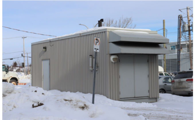
178. Cabanon de la génératrice ajouté en 2009 en cour arrière de l'hôtel de ville.
